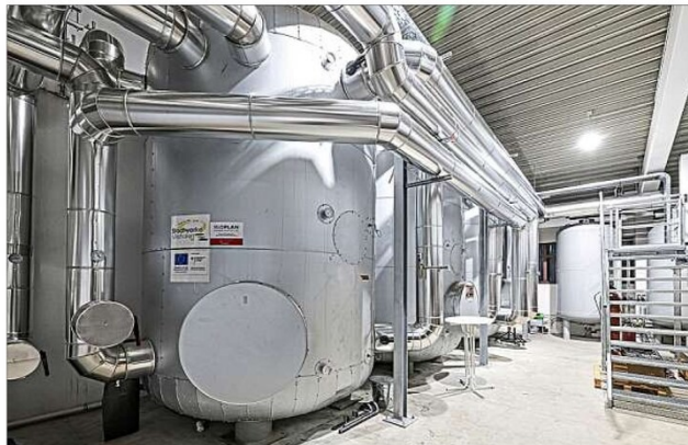
Die drei Pufferspeicher, die jeweils 20 Kubikmeter Warmwasser fassen.
